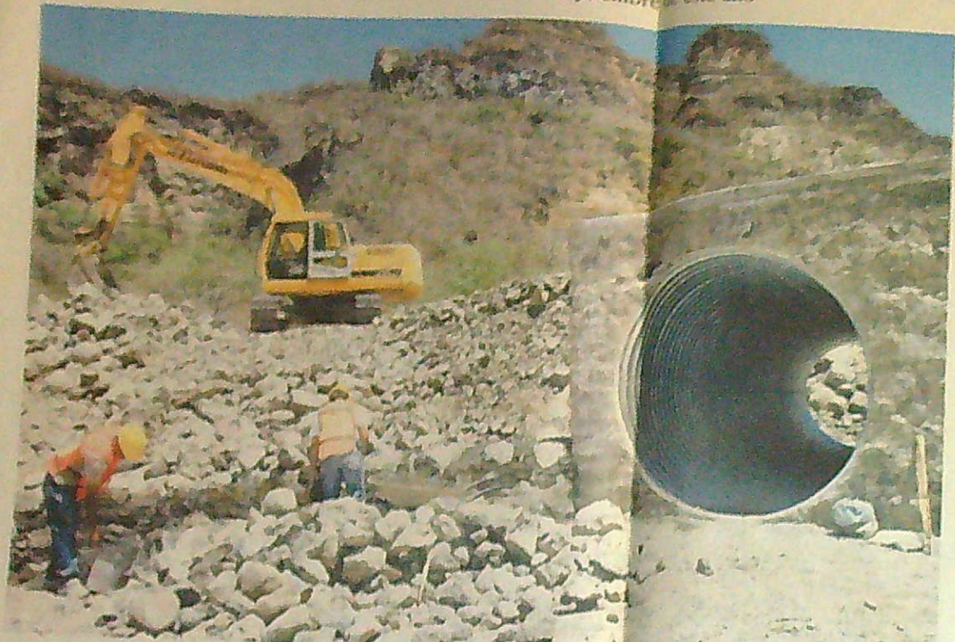
Aspecto de las obras para la Presa de Arcediano en el fondo de la Barranca de Huentitán. El proyecto originalmente, cambió de ubicación.
